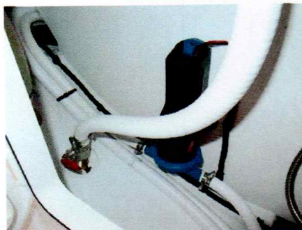
Pompe d'évacuation douche Implantation : sous le lavabo
