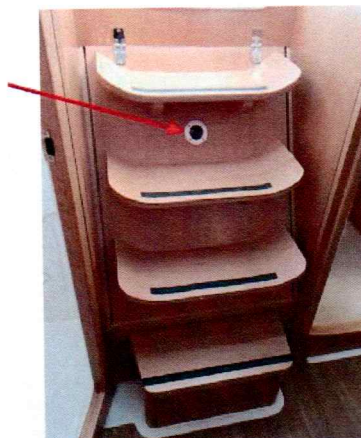
Emplacement de l'orifice extincteur
