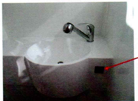
Commande évacuation douche
